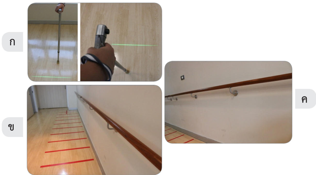
ภาพที่ 3 ก. แสดงไม้เท้าเลเซอร์ ข. เส้น visual cue เพื่อลดอาการเดินติด (freezing of gait) และ ค. ราวเกาะเดิน
